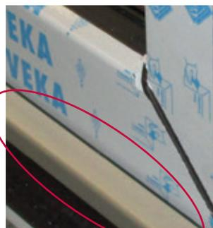
Schützt den Blendrahmen der Balkontür vor Beschädigung.
