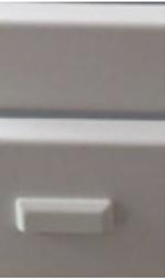
Die Entwässerungsöffnungen im Blendrahmen des Fensters werden für eine ansprechende Optik durch die Kappen abgedeckt.
