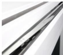
Der Spaltlüfter bietet neben der gewöhnlichen Kippstellung eine weitere Feststellmöglichkeit zur Lüftung.
